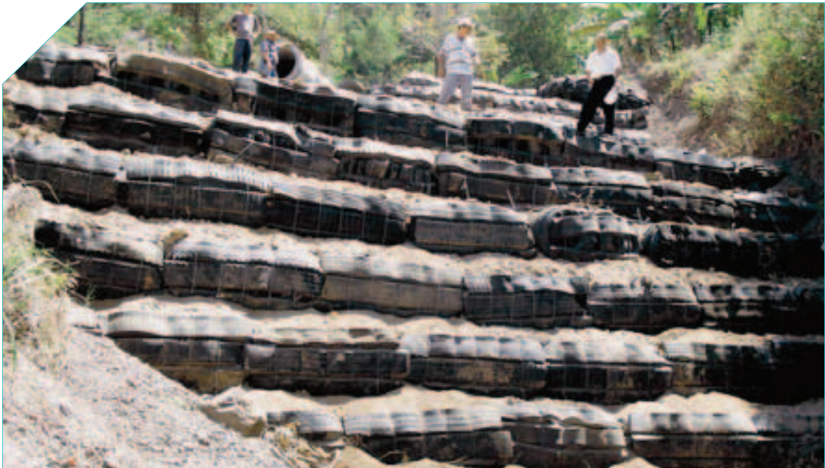
ESTE LLANTIÓN ES UN EJEMPLO de cómo el caucho, combinado con otros materiales, se convierte en una barrera estable y segura.
